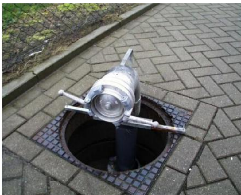
Figuur B 3.5: Voorbeeld geboorde put met flexibele inhanger
