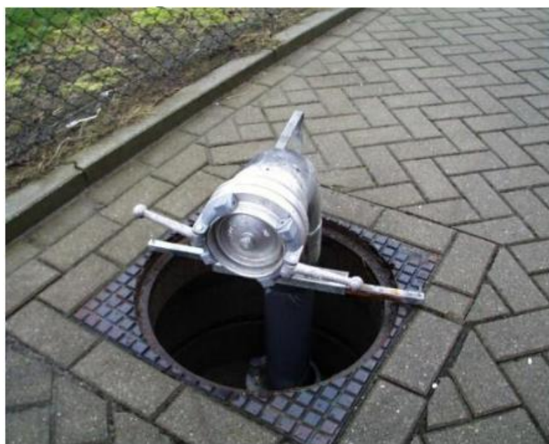
Voorbeeld geboorde put met flexibele inhangen.
